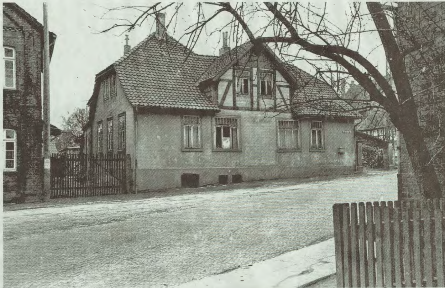
Erste Wirkungsstätte in Lauenau: Die ehemalige „Rektorschule“ am „Rundteil“.
