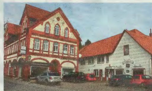
Das Kolonialwarenhaus (links) wird saniert. Das Enzianstübl wird mitsamt Kegelbahn abgerissen.
