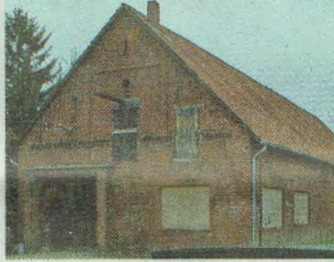
Vor dem Umbau war die Fabrik-scheune äußerst marode. FOTO: NAH
