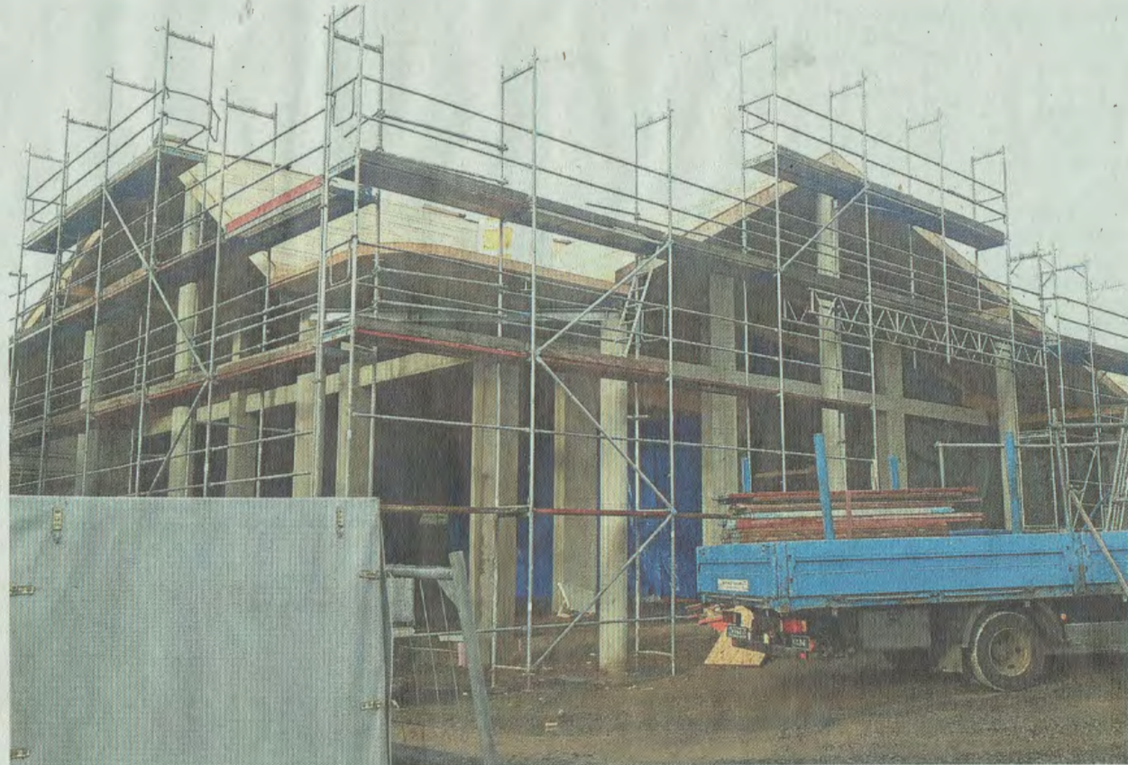
Die Arbeiten am Dach des Marktes sollen bald abgeschlossen sein. FOTO: GUS
